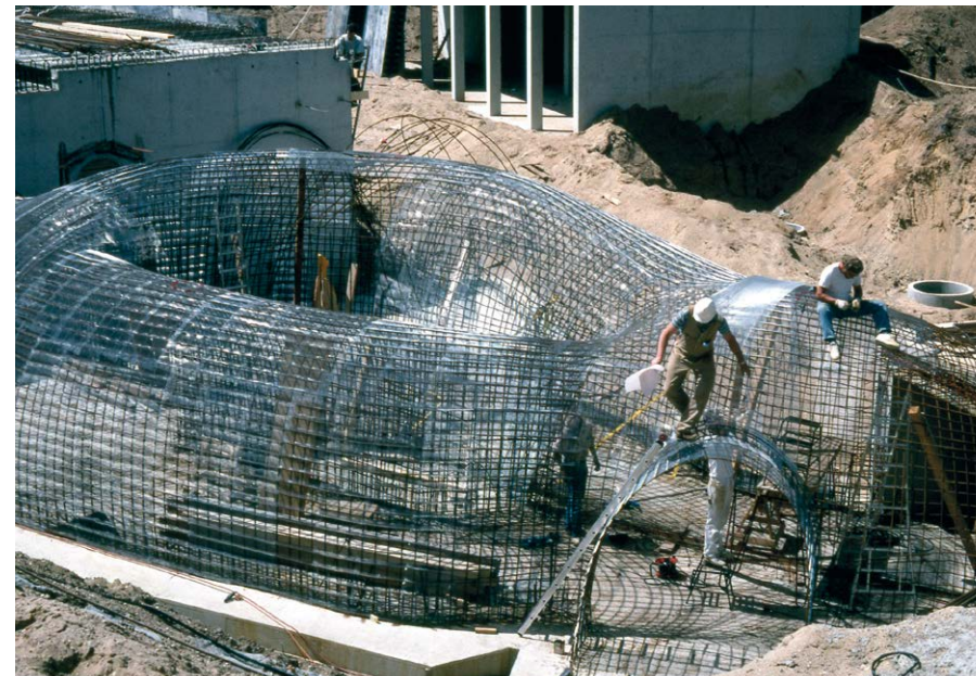
De U-vormige tunnel met nachttactieve dieren in aanbouw.
